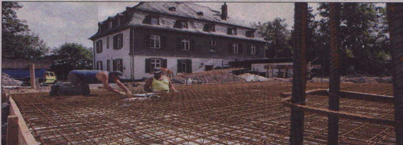
Gestern wurde der Beton gelleiert, jetzt soll der Pavillon hinter dem Jagdschloss so schnell wie möglich gebaut werden, damit die Existenzgrundlage des neuen Pächters gesichert wird. Foto: RMB/Windolf
